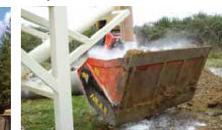
Stabiliseren van klei / leem met kalk
