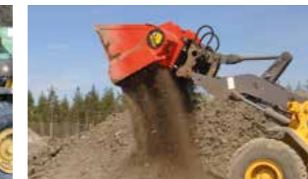
Beluchten van verontreinigde bodem compost
