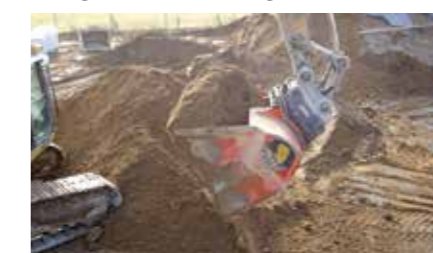
Stabiliseren van funderingslagen
