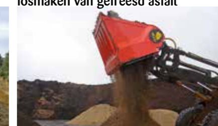
Bovenste bodemlaag mengen met zand
